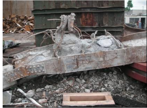
写真2 コンクリート入鉄骨
