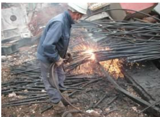
写真7 タイワイヤーのガス切り
